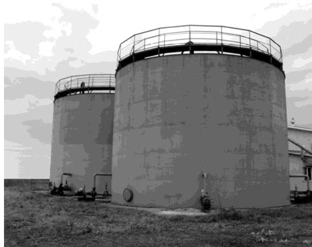
Рис. 3. Аеротенки-відстійники
